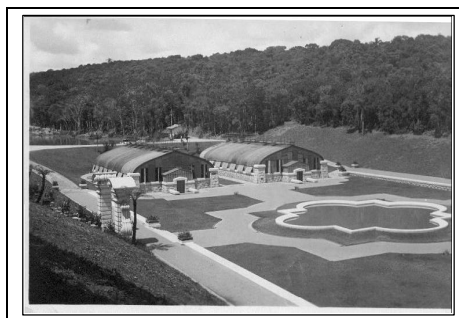
Figura 2. Vista das Estufas (1932).
